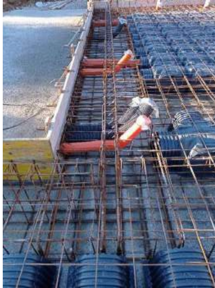
Armatura di fondazione
